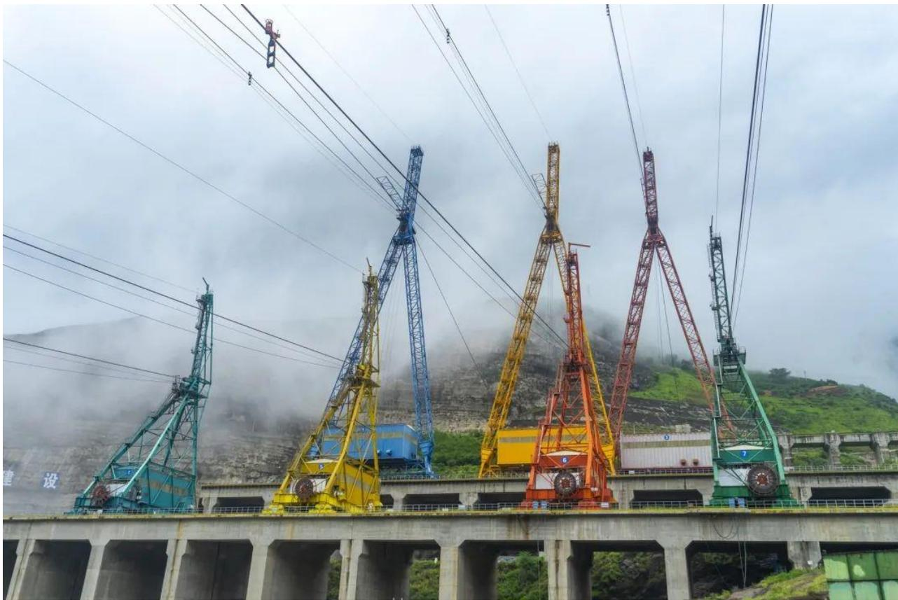
按照设计要求，白鹤滩大坝布置了7台平移式缆机，采用“双平双层”布置，高线3台、低线4台，宛如“七仙女”，**是目前世界上最大的缆机群**。缆机承担着大坝混凝土及设备材料的吊运工作，有着“空中走廊”之称。每台缆机额定吊重30吨，采用9立方米的吊罐进行混凝土垂直运输。**创造了同类机械安全运行时长及混凝土吊运量两项世界纪录。**
