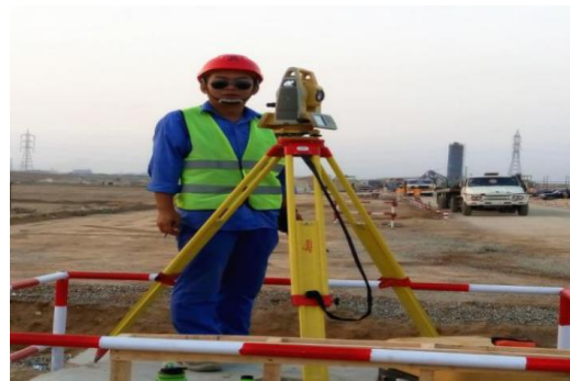
图 2-27 宁新龙施工现场测量
