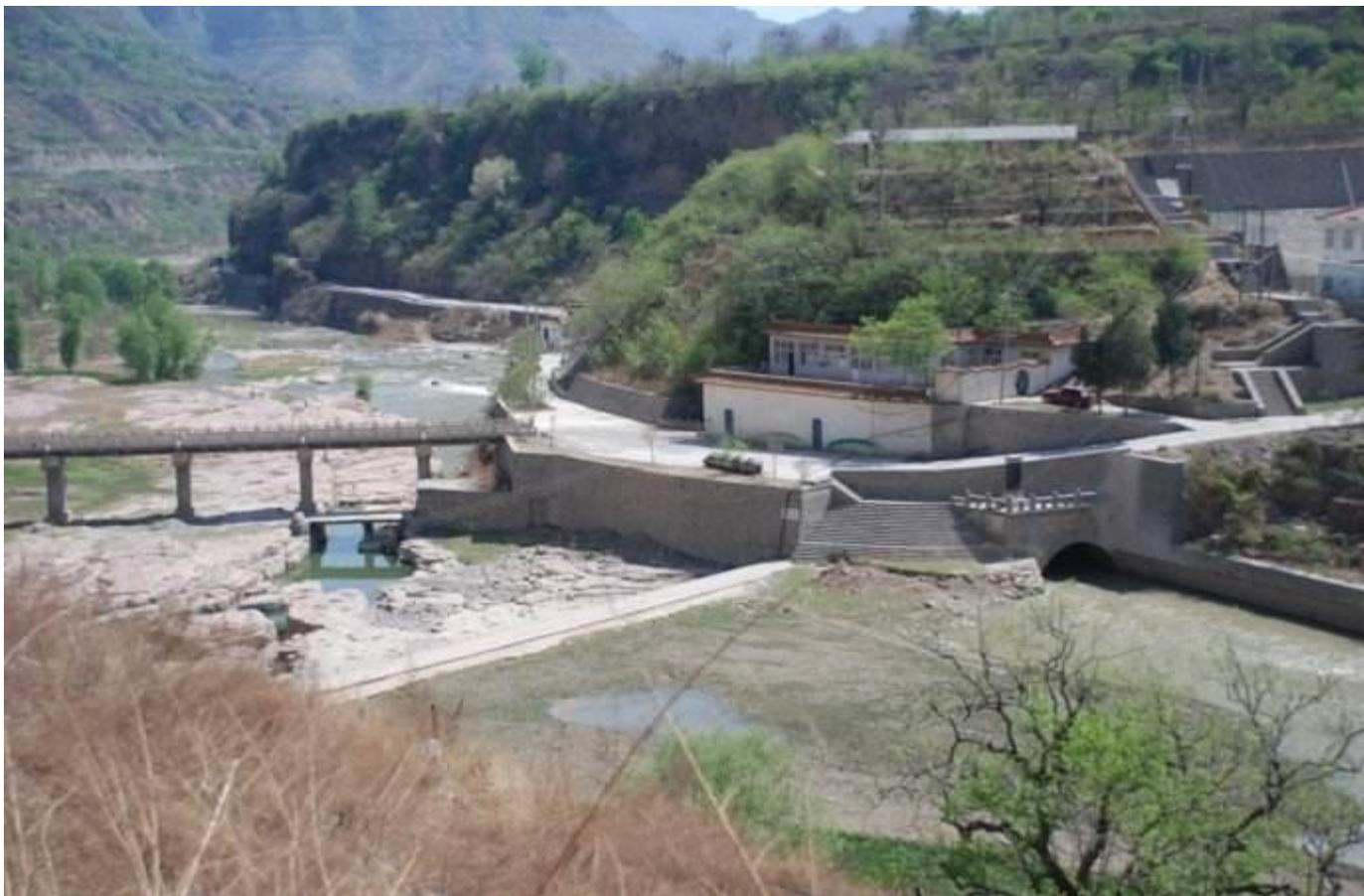
位于山西省平顺县侯壁水电站下约600米处，由拦河溢流坝、引水隧洞、引水渠、进水闸、泄洪冲沙闸联合组成渠道引水枢纽。
