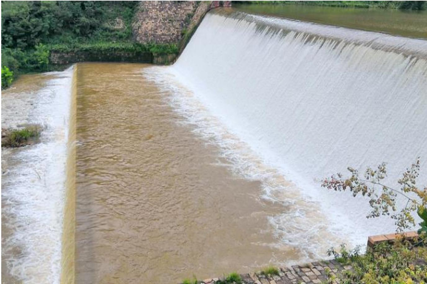
空心坝位于总干渠任村白家庄村西露水河支流段——浊河上。是渠河交叉建筑物。坝顶泄洪，坝内输水。
