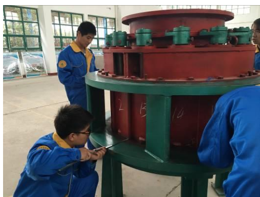
径向式导水机构活动导叶间隙测量调整
