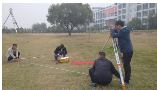
图 6 建筑工程施工放样
