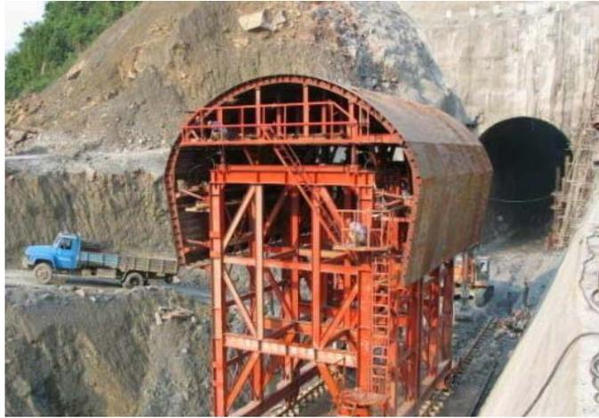
图 3-9 隧洞钢模台车
