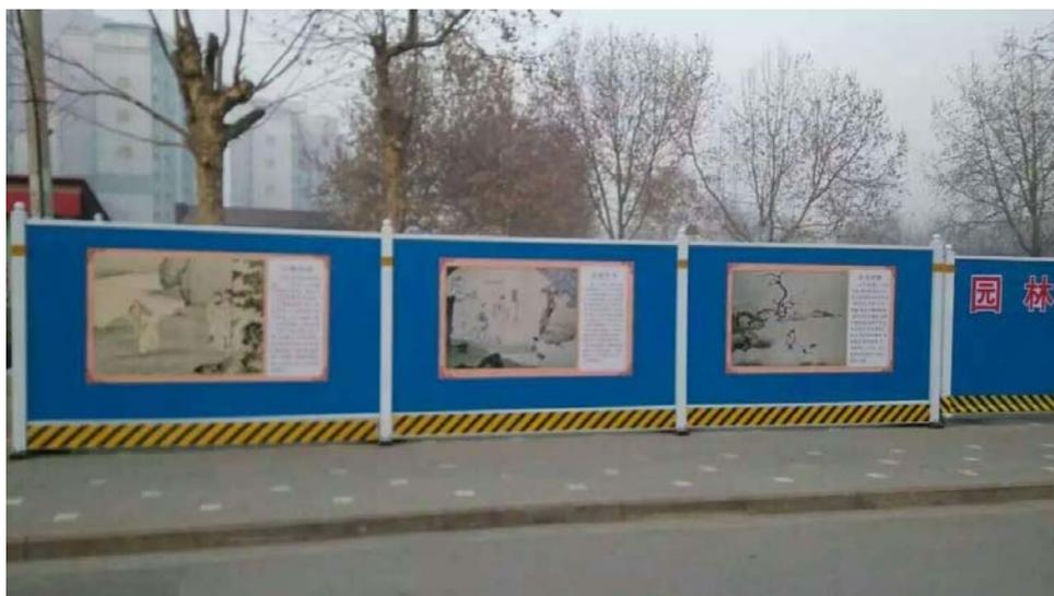
图 3-2 施工现场的围挡图
