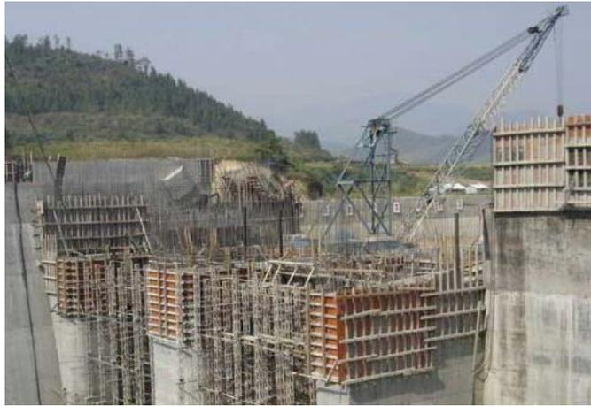
图 3-10 水工建筑物滑升模板
