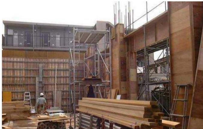
图 3-11 墙体浇筑木模板
