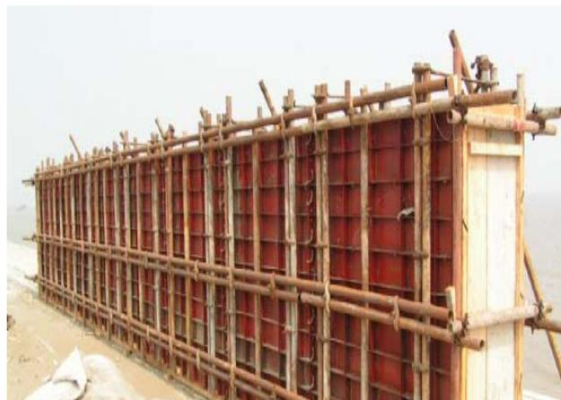
图 3-8 海堤防浪墙模板模板
