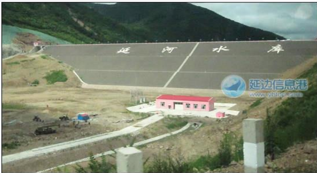
延河水库贴坡排水
