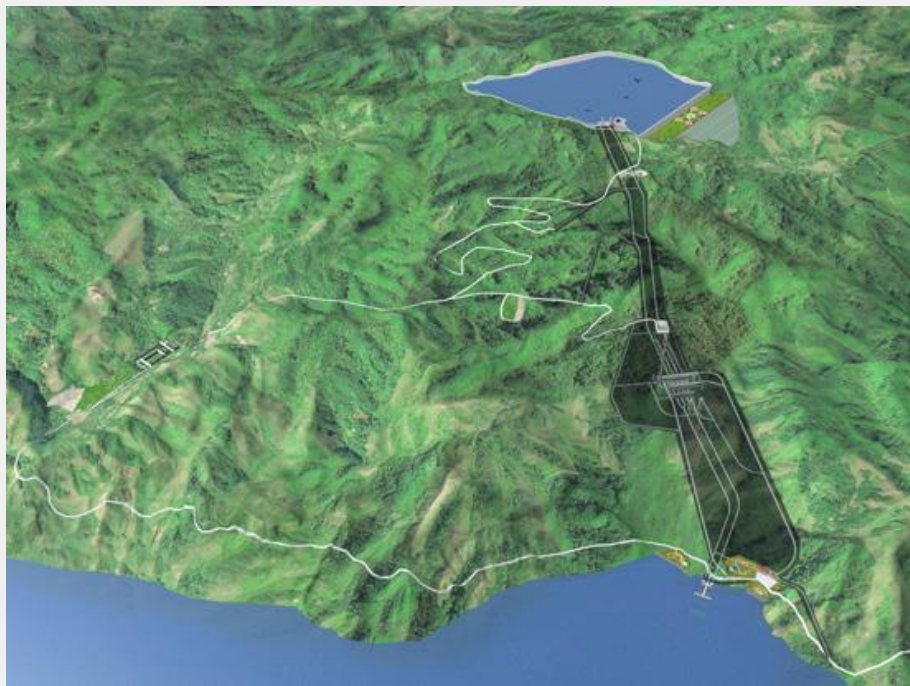
荒沟抽水蓄能电站
